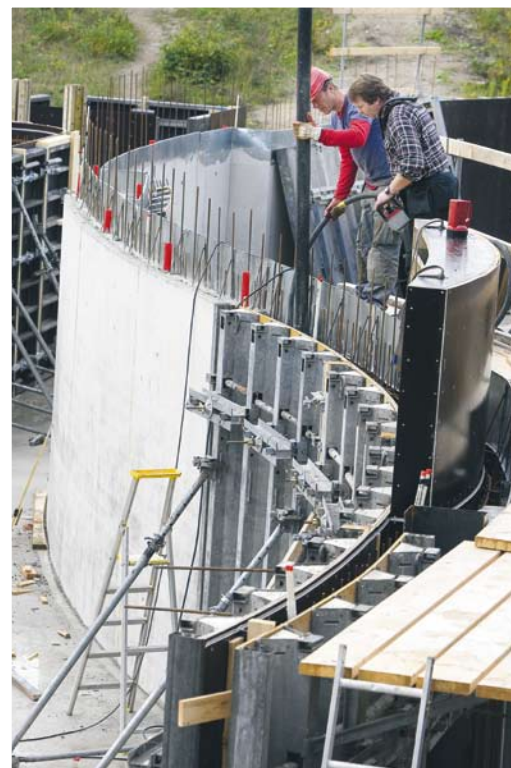
INGA RÄTA VINKLAR. Betongen pumpas ned i de böjande gjutformarna. Tobias Pettersson och Kenny Johansson vid pumpen.
