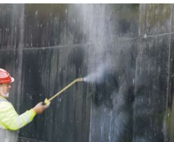
OLJEFILM. För att betongen ska släppa från formen, måste Benny Olofsson olja in alla gjutformarna.
